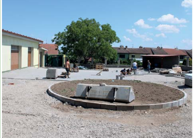
↑ Dokončovací práce na dvoře OÚ
