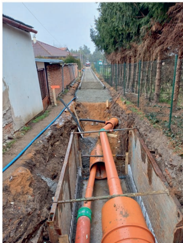
Oprava kanalizace v Plačkově uličce
