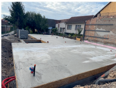
Stavba školních dělen
