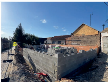
Stavba školních dělen
